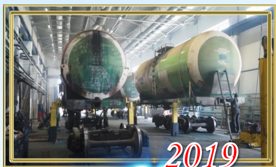
Сборочный цех ООО «ВРК КУПИНО» (после реконструкции)
