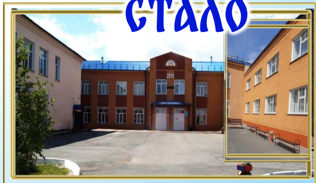
Школа интернат № 2 в г. Купино (после реконструкции)
