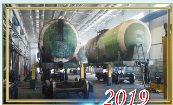
Сборочный цех ООО «ВРК КУПИНО» (после реконструкции)
