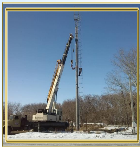
Установка опоры сотовой связи в д. Новониколаевка
