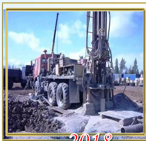
Строительство глубоководной скважины в д. Лукошино
