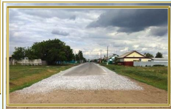
Ремонт автодороги по ул. Центральная в д. Киргинцево
